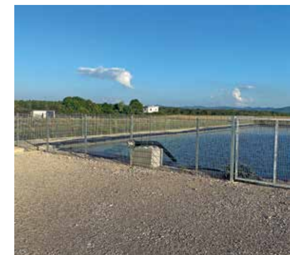
Löschwasserentnahme durch eine Steigleitung.
