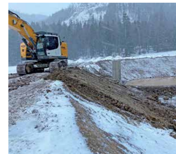
Die Errichtung eines Löschteiches mittels Lehm Schlag.
